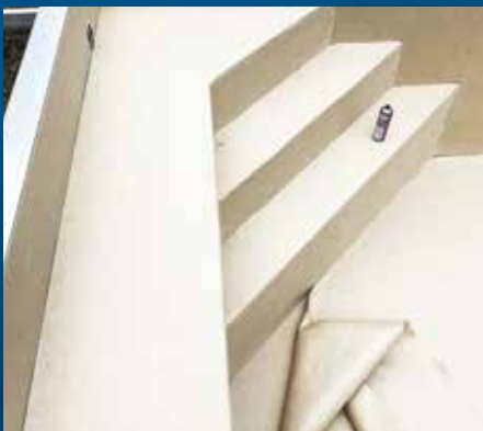
Pose du feutre.
