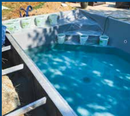
Mise en eau du bassin.
