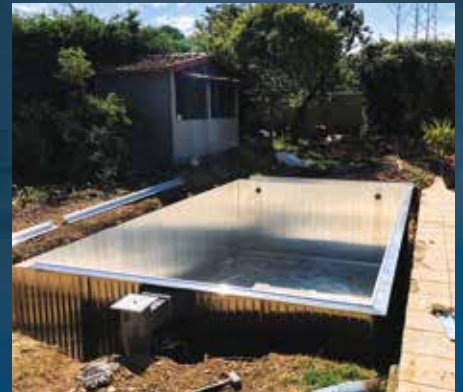
Montage du mur de structure : pose des poutres hautes, réglage de la planéité de la structure.
