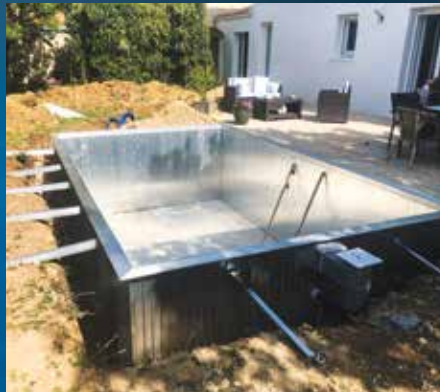
Montage du mur de structure : fixation des cornières et raidisseurs, assemblage des pales.
