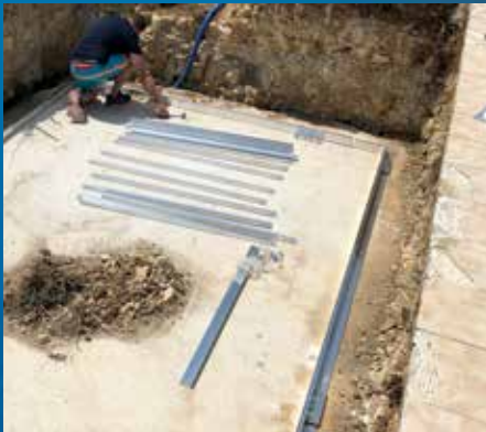
Montage du mur de structure : traçage au sol, assemblage des poutres (supérieures et inférieures), pré-boulonnage.
