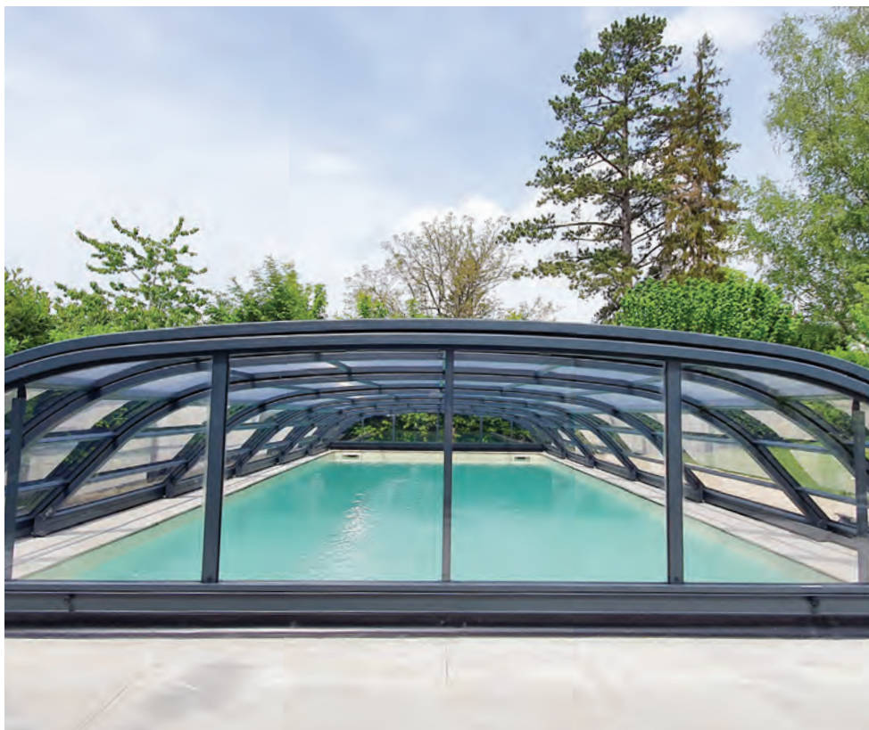
Loon Piscines & Spas / PISCINES HydroSud Besançon
